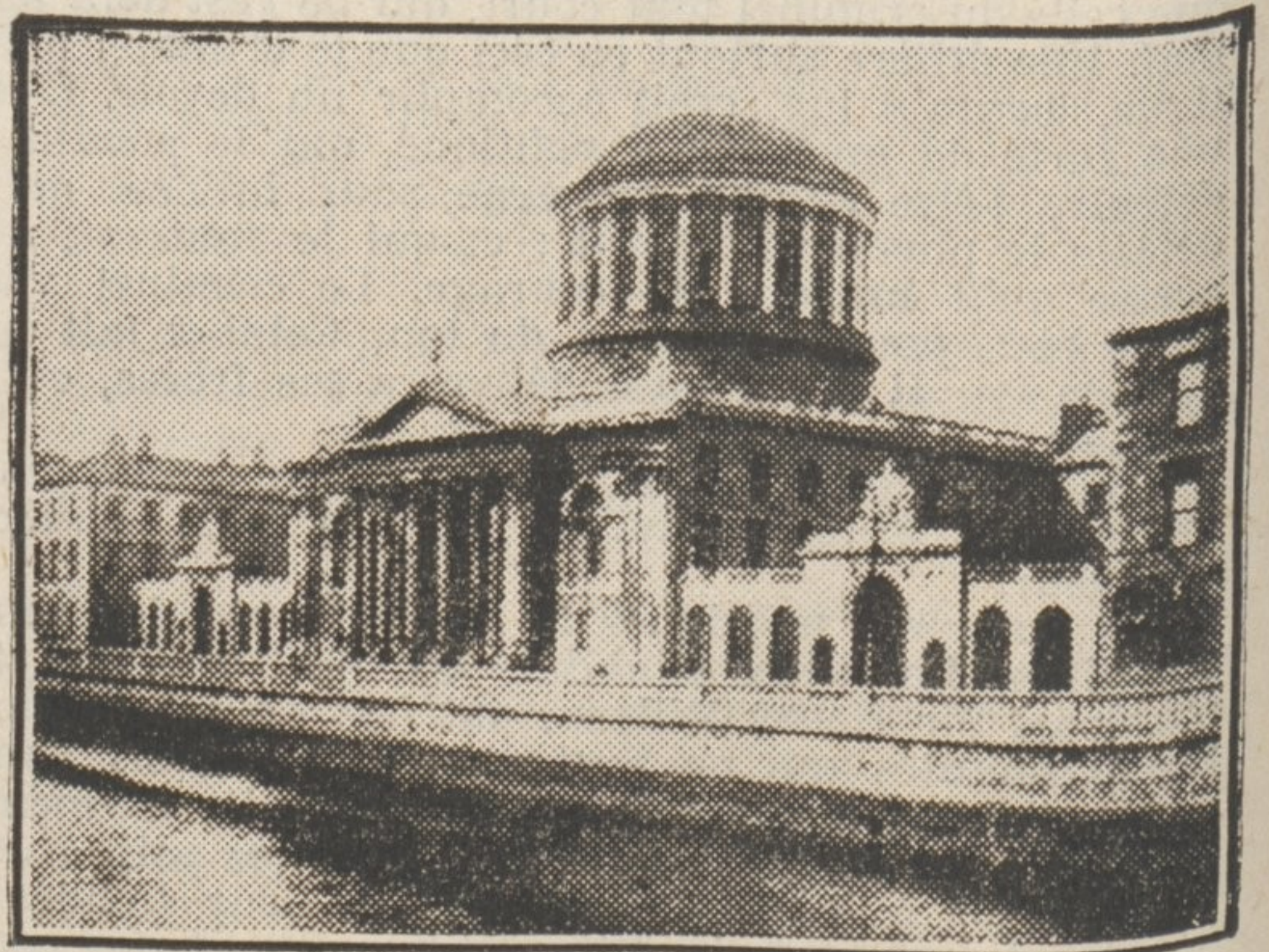
A Dublin, le siège du Palais de Justice a été détruit par un bombardement.
